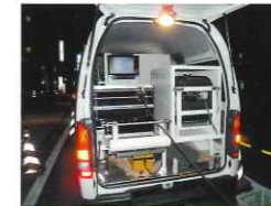
下水道管カメラ調査
