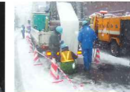
下水道管更生工事
