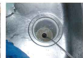
排水管清掃作業
