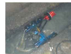
下水道管カメラ調査
